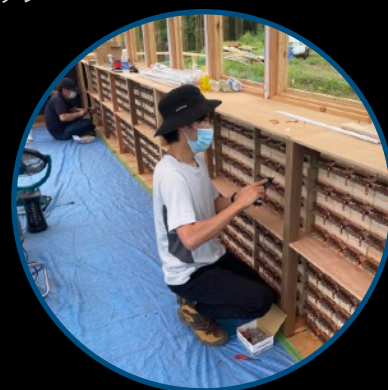
空庵コンテナの整備
