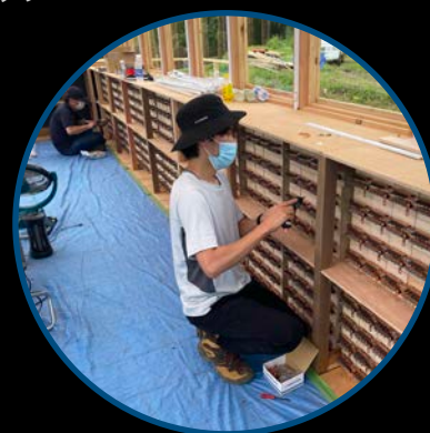
空庵コンテナの整備
